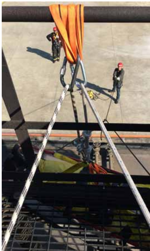
A Braskem conta com especialistas em alturas e em espaços confinados
